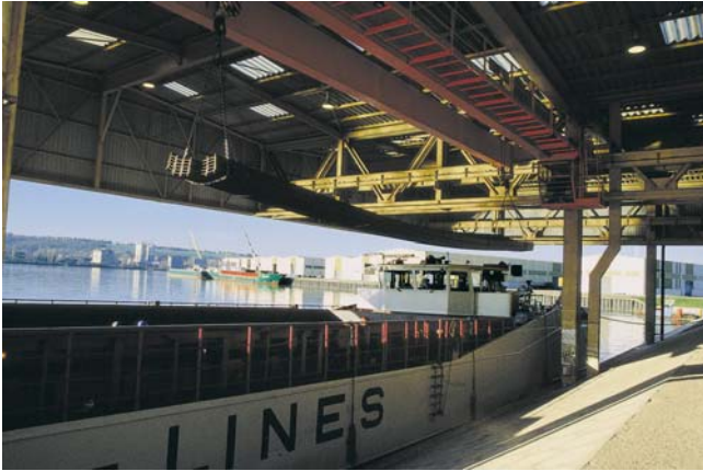
Plate-forme de Gennevilliers
